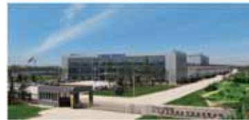
陕西光伏产业园区 (西安)
